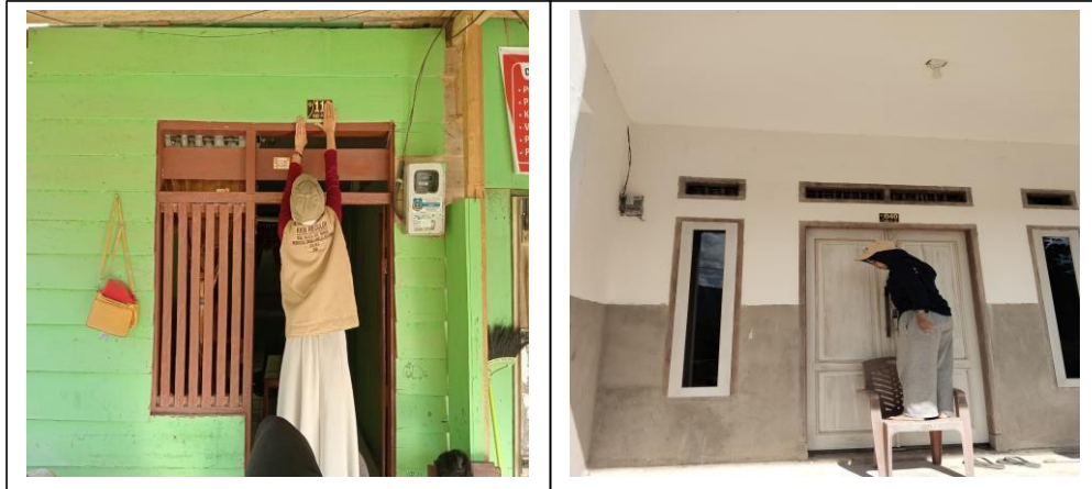
Gambar 3. Proses pemasangan nomor rumah pada rumah warga
