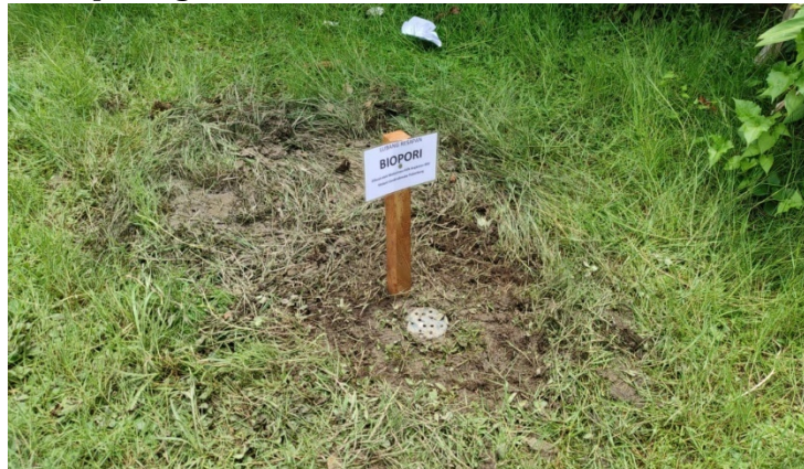
Gambar 5. Lubang biopori setelah ditutup
