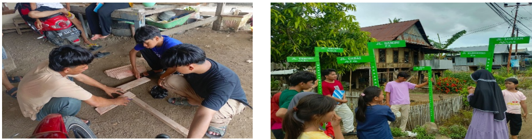
Gambar 4. Pembuatan dan pemasangan Plan Jalan
